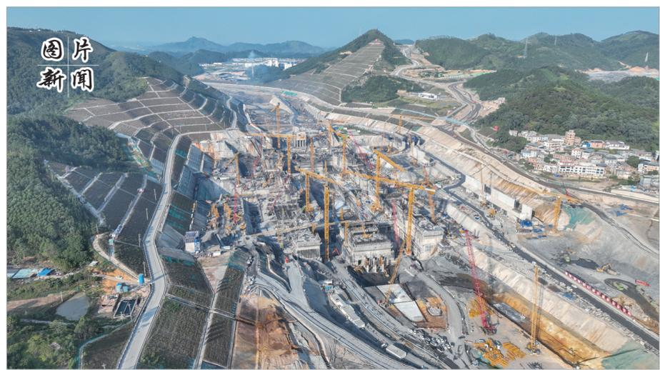
10月20日,公司承建的平陆运河马道枢纽船闸主体混凝土浇筑量已突破100万立方米,为2025年底完成船闸主体混凝土浇筑打下坚实基础。
