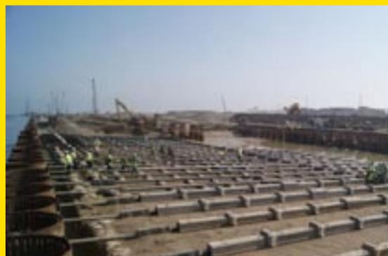
卡拉奇深水港码头锚杆防护罩安装
