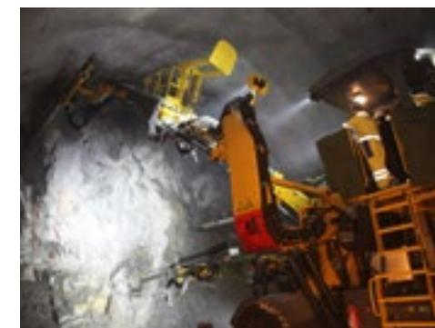
2013年11月清凉山隧道二号斜井三臂凿岩台车正在钻孔施工
