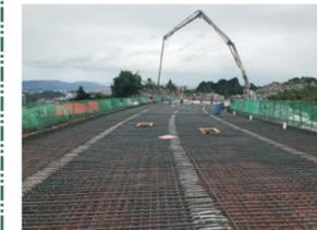
第一联现浇箱梁分为两次浇筑，C50砼共计612.4m³，第一次完成现浇箱梁底板及腹板浇筑，第二次完成顶板及翼缘板浇筑。虎岔口互通B匝道桥全长180.8m，上部构造为3×24m+4×24m预应力混凝土现浇箱梁，桥宽由16.927m渐变至12m，箱梁高1.5m，C50砼1337.3m³，采用碗扣式脚手架搭设满堂支架施工。目前，虎岔口互通B匝道桥第二联现浇箱梁正在进行满堂支架搭设，
